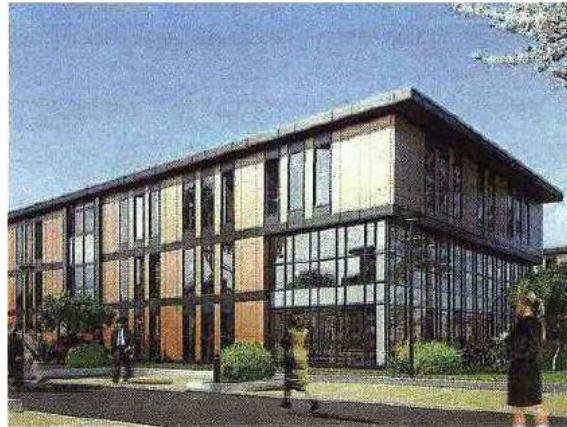
22 bâtiments à énergie positive devraient voir le jour d'ici 2018 sur la zone de l'Arteparc, près de Lesquin.
