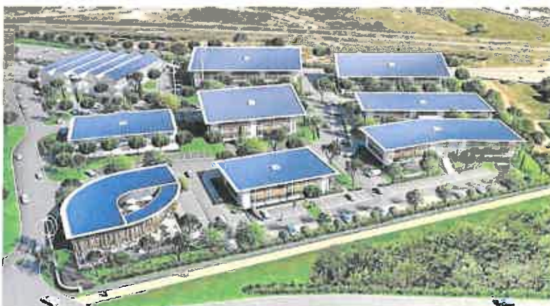
Arteparc, près d'Aix-en-Provence, est un ensemble d'immeubles de bureaux qui produit plus que l'énergie nécessaire à ses 600 occupants. - Photo Artea
